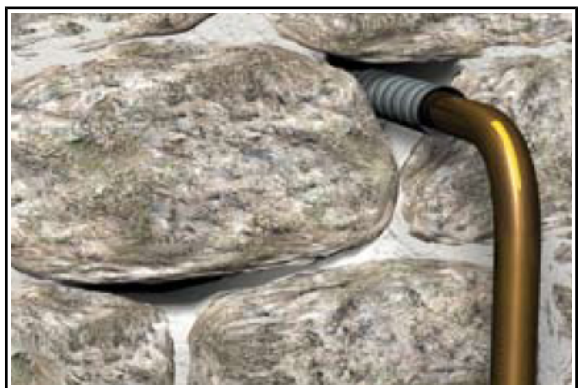
Situation initiale avant colmatage
