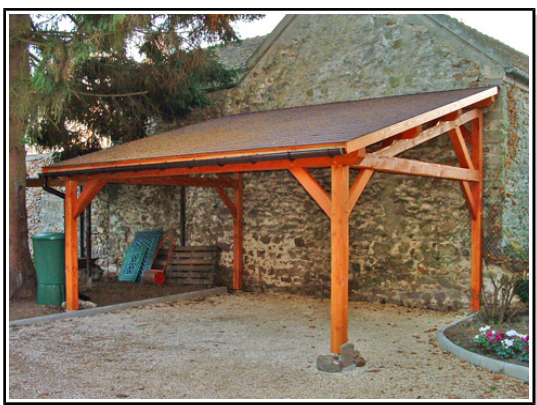
Construction annexe adossée à façade
