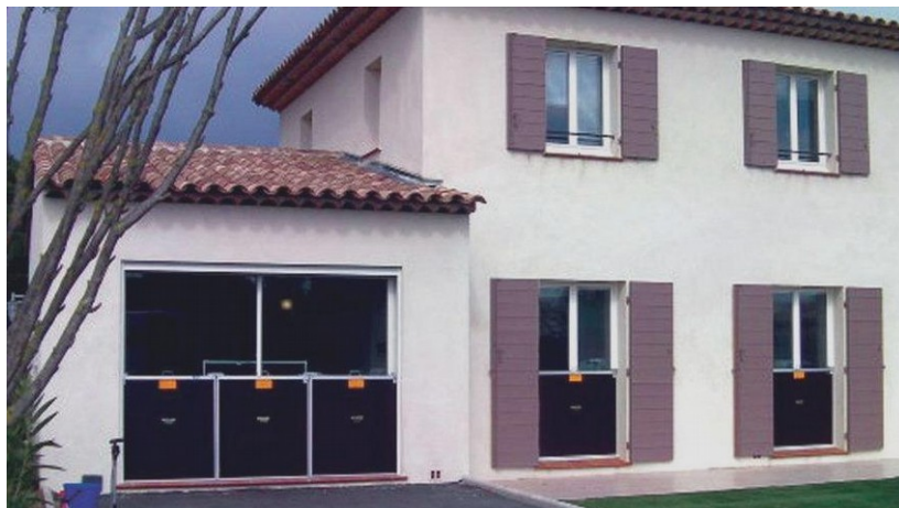
Exemple de protections des ouvertures
